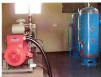
FIGURA 33 - Sistema de Ar-comprimido do tanque hidropneumático do sistema fixo automático de proteção contra incêndio por água nebulizada – Mulsyfire Fonte: empresa Quadritec Construções e Empreendimentos Ltda
