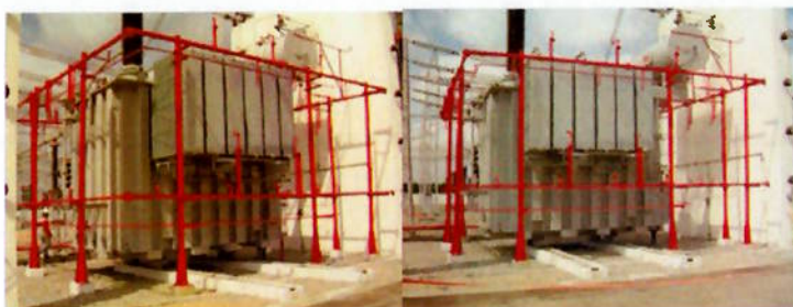
FIGURA 31 – Sistema fixo automático de proteção contra incêndio por água nebulizada em transformador de potência
