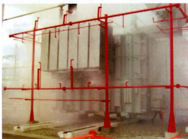
FIGURA 32 – Teste de funcionamento do sistema fixo automático de proteção contra incêndio por água nebulizada em transformador de potência
