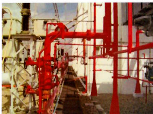
FIGURA 30 – Detalhe de um sistema fixo automático de proteção contra incêndio por água nebulizada Fonte: empresa Quadritec Construções e Empreendimentos Ltda
