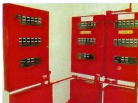
FIGURA 28 – Central do sistema de detecção por cabo detector
