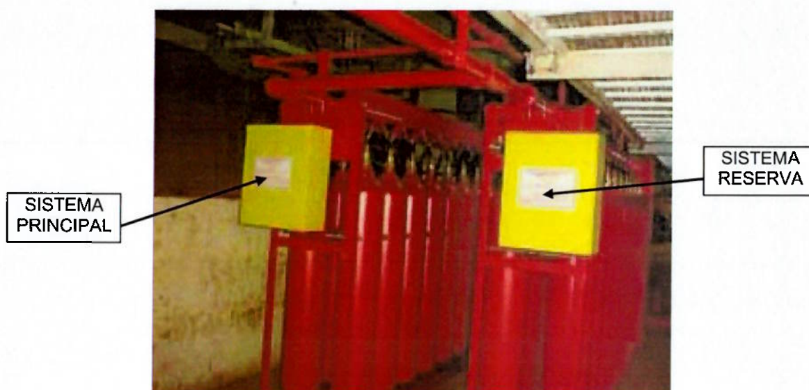
FIGURA 5 – Bateria de Cilindros de CO 2
