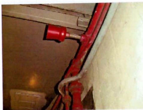
Figura 3 – Difusor de baixa pressão do sistema fixo de \text{CO}_2
