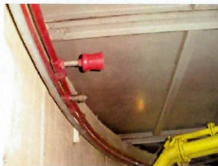
Figura 4 – Difusores de alta e de baixa pressão do sistema fixo de CO 2
