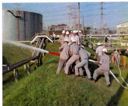
Figura 38 – Hidrante de espuma – treinamento de brigada de incêndio
