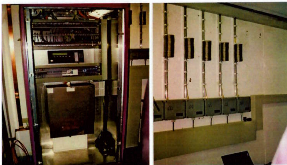
FIGURA 24 – Sistema de detecção de Incêndio em transformadores por tubo sensor. Fonte: Empresa Securiton AG – Swiss Securitas Group
